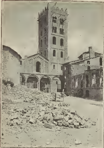
FACHADA DEL MONASTERIO DE SANTA MARÍA
